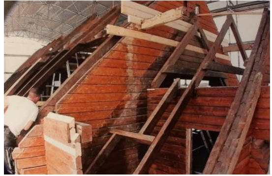
Bild 16 Dach- und Innenausbau
