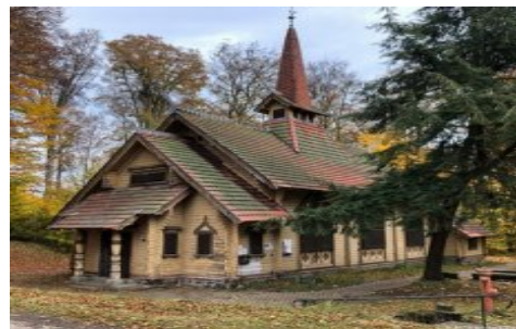
Bild 13 Stabkirche am alten Standort
