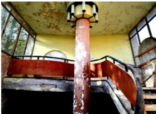
Bild 7 und 8 Treppenhäuser unsaniert, noch original
