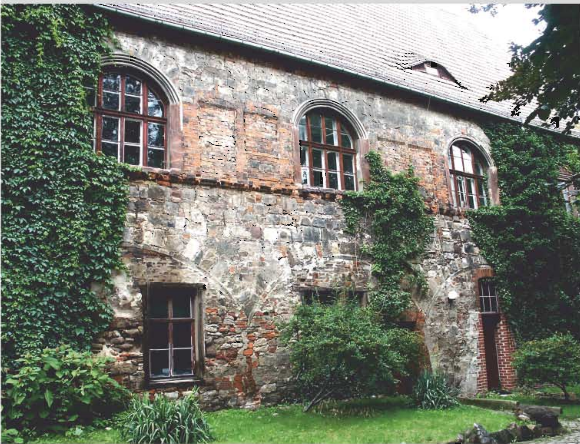
Von der einstigen Renaissancearchitektur des prachtvollen Arkadenhofes zeugen noch versteckt und verändert die Bogenstellung auf Balustersäulen in der Hoffassade des Ostflügels, DuB 2009.
