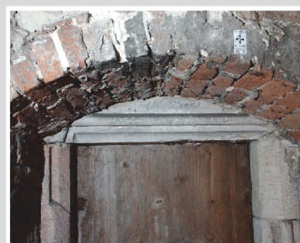
Aus verschiedenen Gewänden bestehende nachträgliche Türöffnung in der Kirchensüdwand, DuB 2009.
