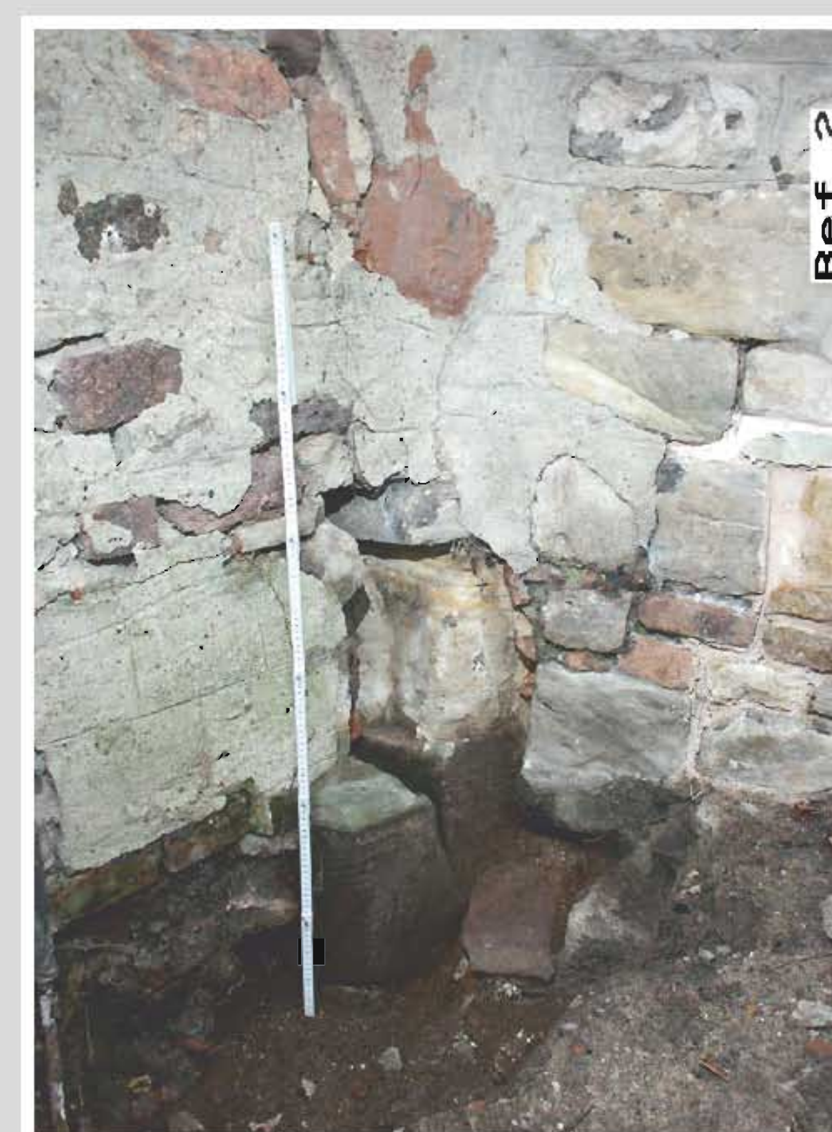
Freigelegter Werksteinsockel unter der Ecksäule zwischen Ost- und Südflügel, DuB 2008.
