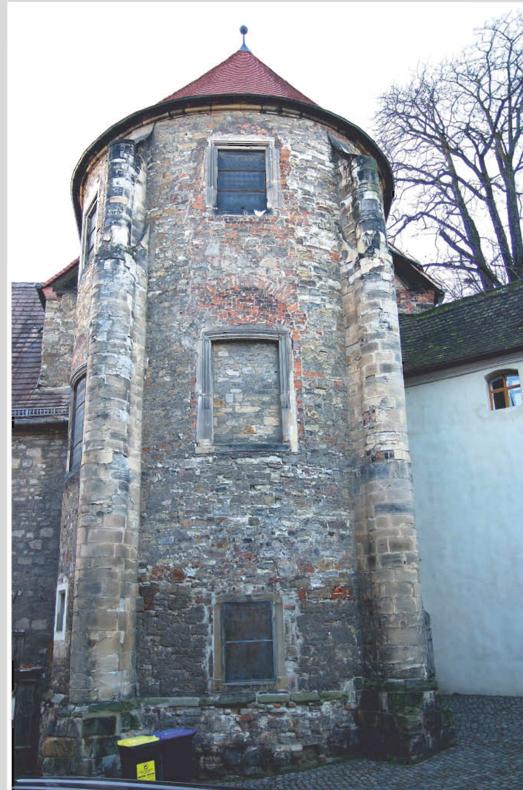
Ansicht der Kapellenapsis (1537-39) des von Kardinal Albrecht initiierten „Neuen Baues“ der heutigen Residenz. Das Scheitelfenster in der mittleren Fensterebene mit einem Bruch des Sturzes im Herbst 2008. Die oberen Rechteckfenster belichten den heutigen Ausstellungssaal durch Schächte in der Rabitzkalotte.
