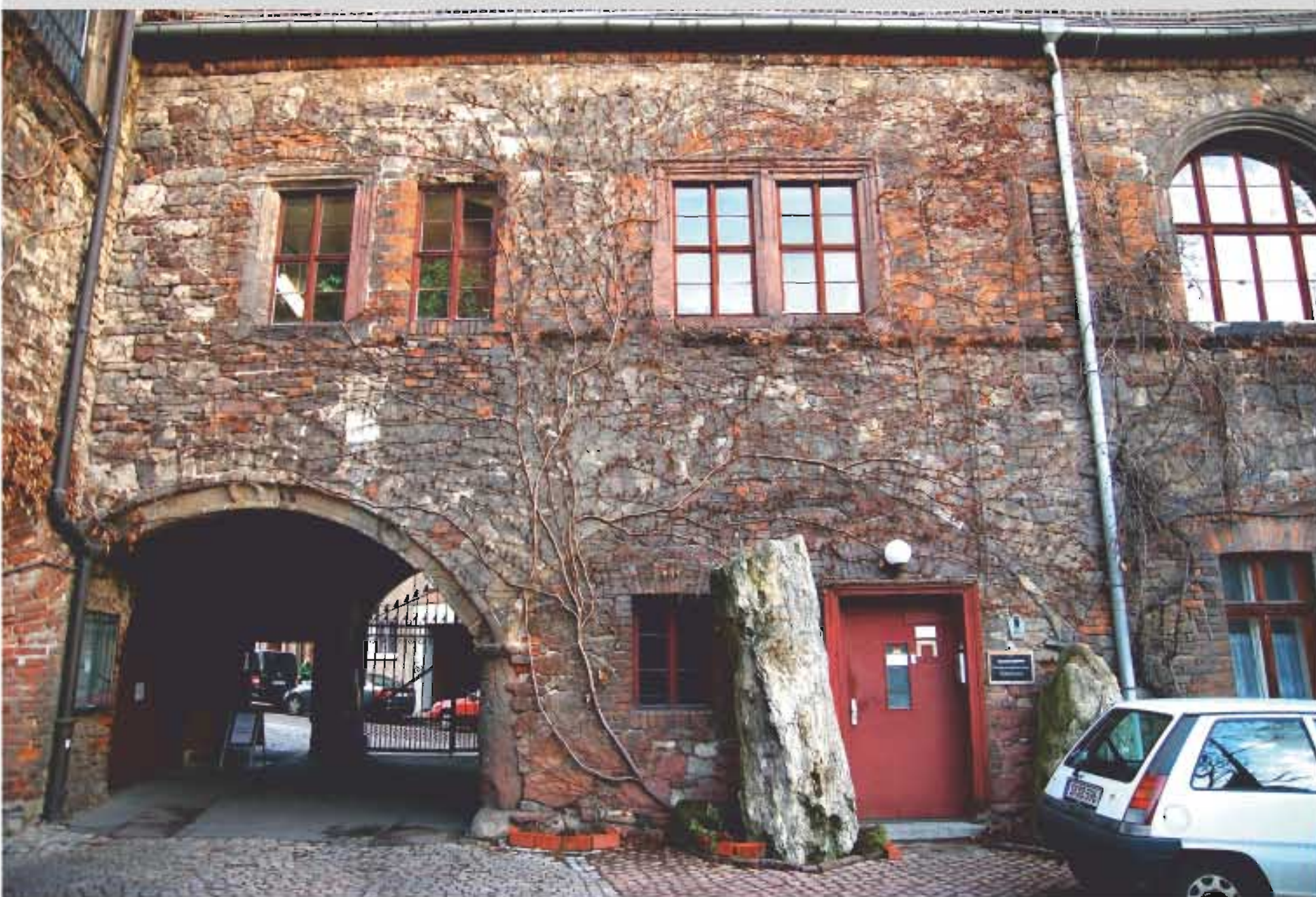
Der Arkadenbogen der Tordurchfahrt wurde durch den Anbau der etwas jüngeren Kapelle (links) teilweise umbaut. Die Balustersäule und weitere Werksteinbögen sind in der Fassade erkennbar.
