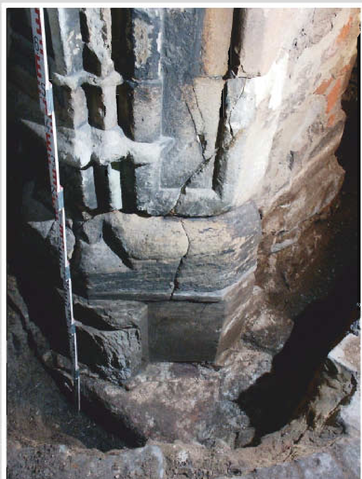
Freigelegte nördliche Flanke des Pfeilers mit den Werksteinen der Gründung und dem auffälligen Rissbild in der Pfortenlaibung, DuB 2010.
