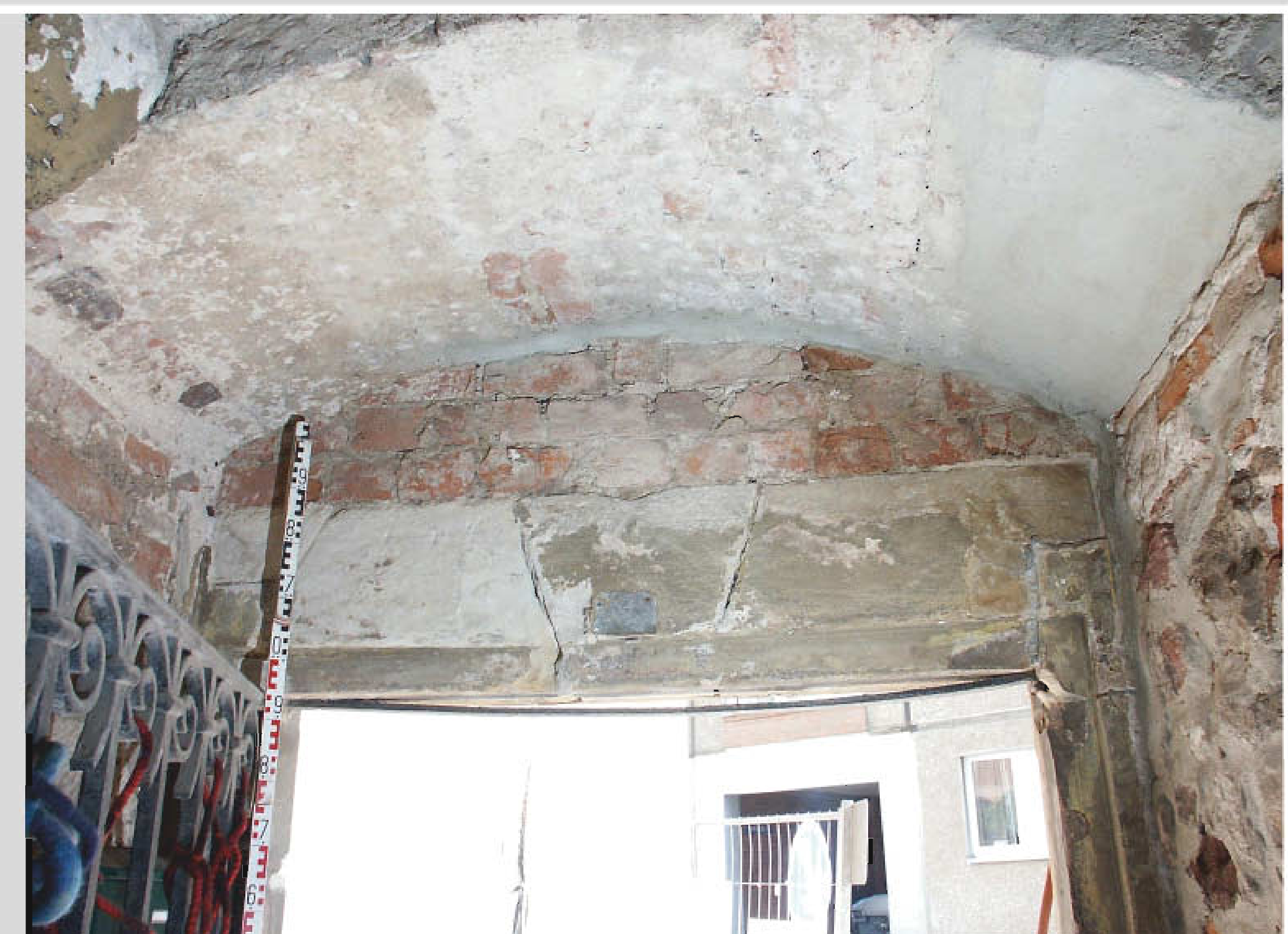
Der Pfortensturz zeigt von innen einen nach oben konischen Schlussstein, was bautechnisch nicht funktionieren würde, wenn er die Stärke des Sturzes hätte. In der Mitte wechselt der Sturz nach außen in einen nach unten konischen Werkstein. DuB 2010.
