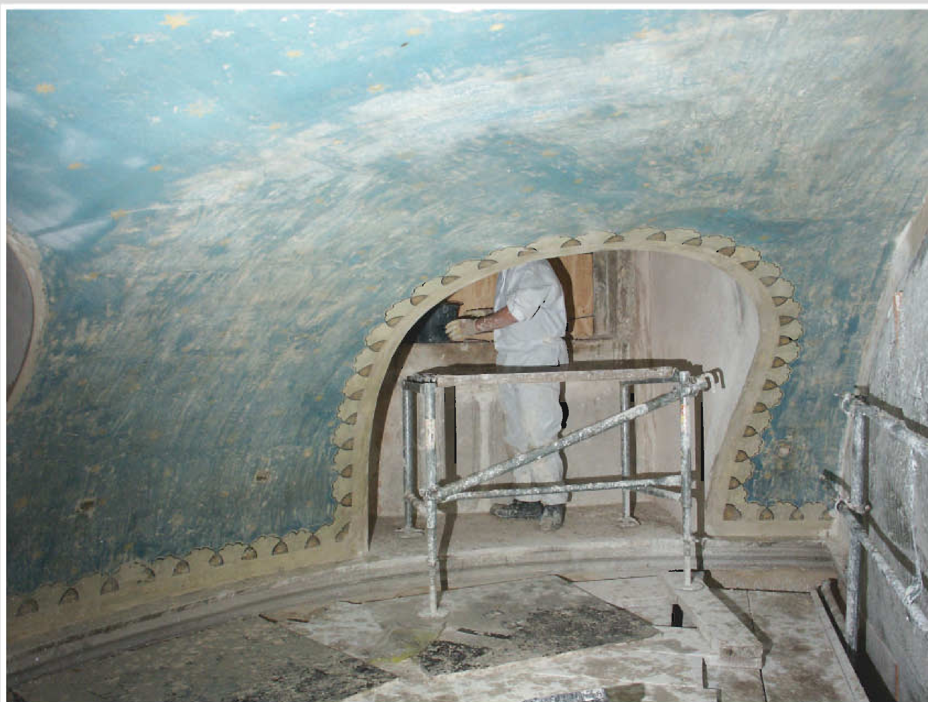
Während der Sanierung an der Innenwand der Apsis kam die Bemalung der Rabitzkalotte des Kirchenumbaus von 1905 zum Vorschein, DuB 2010.
