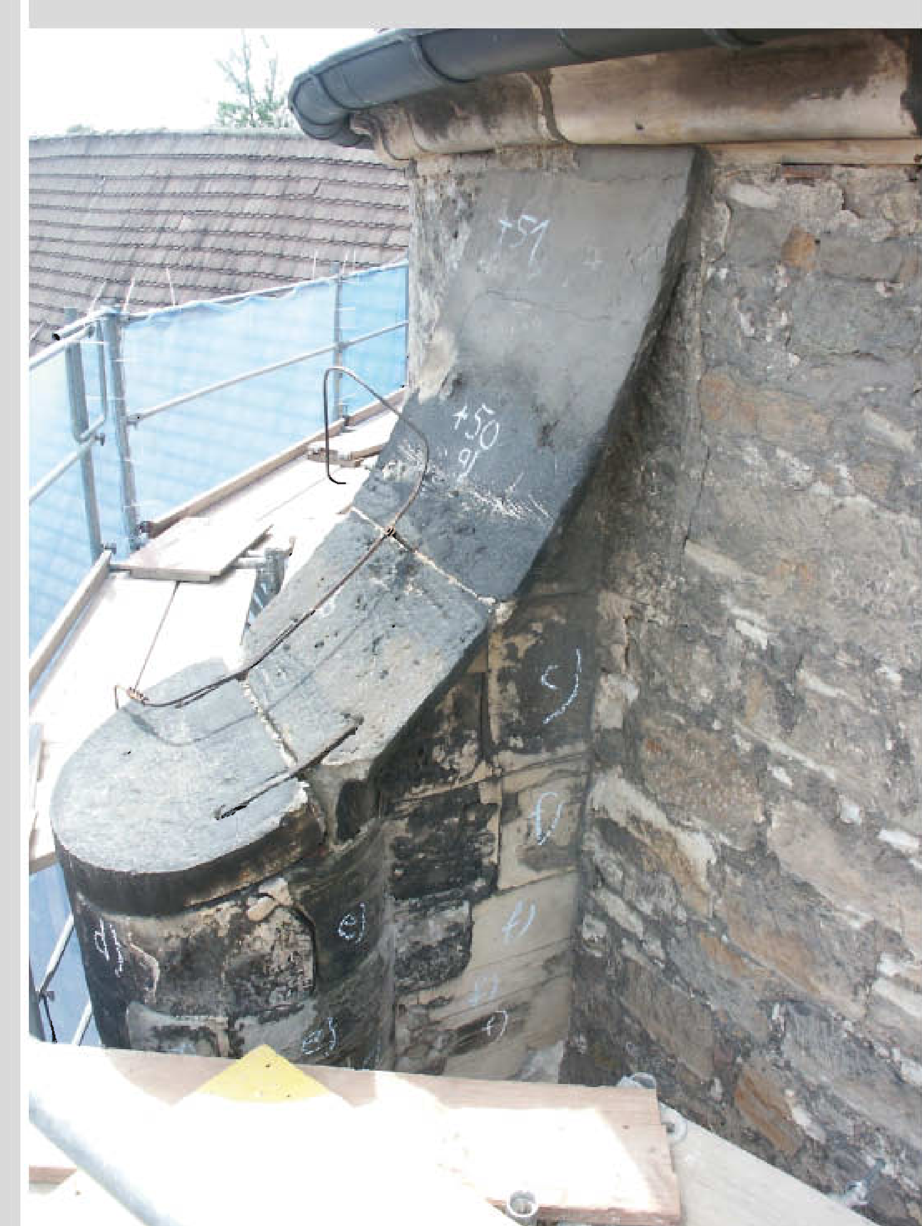
Die Abdeckung des gerundeten Strebepfeileraufsatzes wurde wohl schon bei einer früheren Sanierung um 1905 umgesetzt und mit Klammern gesichert, DuB 2009.
