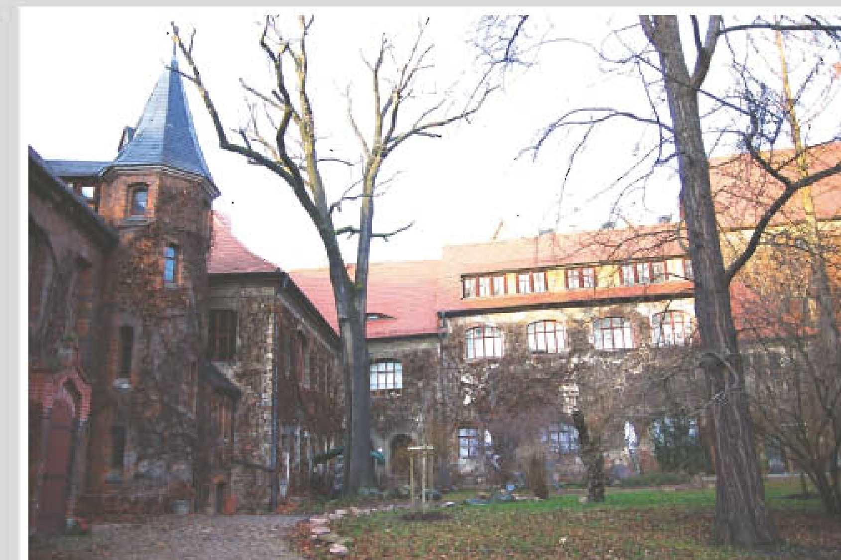
Ansicht des zum übrigen Westflügel breiteren Anatomiegebäudes von 1790, hinter dem Treppenturm von 1880. DuB 2009.
