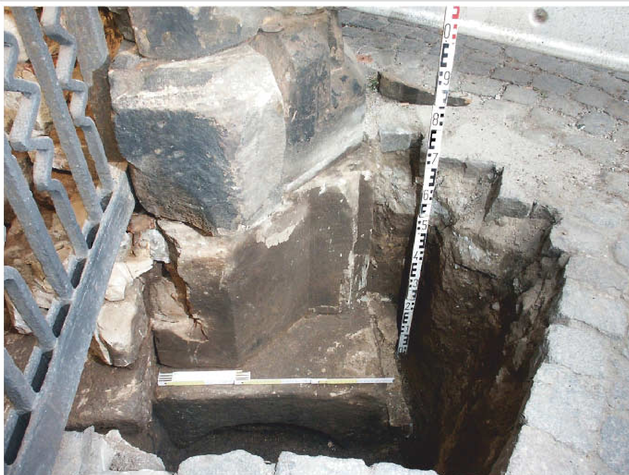
Freigelegtes Fundament des Pfeilers zwischen Pforte und Durchfahrt von Südost. Auf dem Werksteinblock mit Rundbogenausschnitt (Spolie) setzt der Basisblock der Pfeilerprofilierung auf, DuB 2010.
